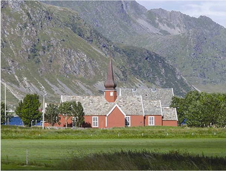
Flakstad kirke i Flakstad kommune, Nordland. Kirken er en rødmalt korskirke i tre, med 300 sitteplasser, bygd i 1780 av tømmer fra Russland.
